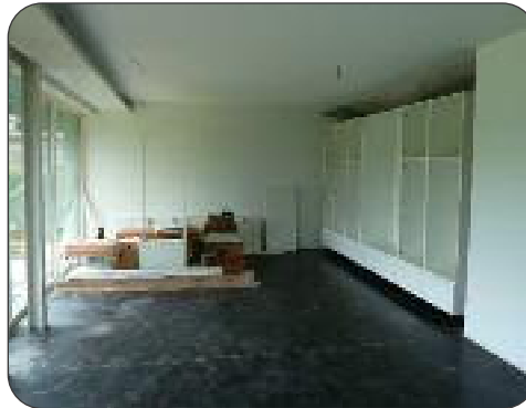
Tussen de leefruimte en de bureau staan dubbelzijdige kasten. Op termijn kunnen de kasten eventueel verplaatst worden, zodat de leefruimte groter wordt. Zo is de woning ontworpen voor levensloopbestendig wonen.
