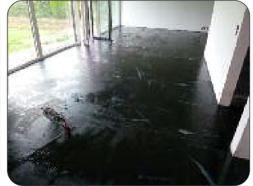
De boenwas moet een tijd in de beton indrogen zodat de poriën verzadigen, nadien wordt de rest weggenomen. Een boenmachine kan nu alles mooi egaal gladrijven.
