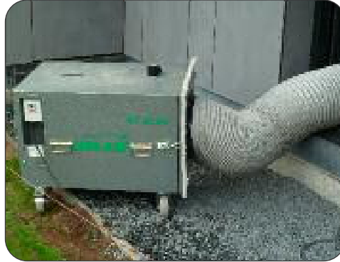
... en door middel van een industriële stofzuiger die een tienvoudig luchtdebiet afzuigt. Deze reiniging wordt bij voorkeur om de vijf jaar herhaald.
