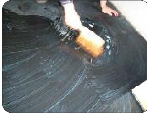
Op het gelijkvloers ligt er polybeton. Beton is een poreus materiaal, daarom is het belangrijk om, na het verwijderen van de beschermende laag, de poriën te vullen. Dit gebeurt door het inwrijven met boenwas.
