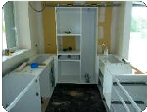
In de keuken worden de kasten gemonteerd. Er werd gekozen voor een II-vormige keuken met een extra wandkast
