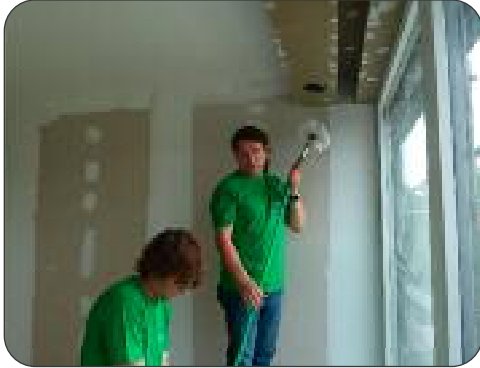
Vooraleer de balansventilatie op te starten is het raadzaam alle ventilatiekanalen nog eens goed te reinigen om bouwstof te verwijderen. Dat gebeurt door middel van een roterende borstel...
