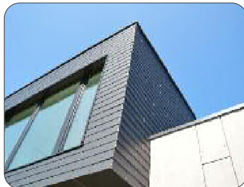
De bovenverdieping kraagt uit over het gelijkvloers. De detaillering aan de ramen, de aansluitingen, werden verzorgd uitgevoerd.
