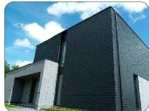
De afgewerkte woning presenteert zich als twee sobere volumes die in elkaar grijpen. De woning is vrij gesloten aan de noord- en westzijde om warmtetransmissieverliezen te beperken.
