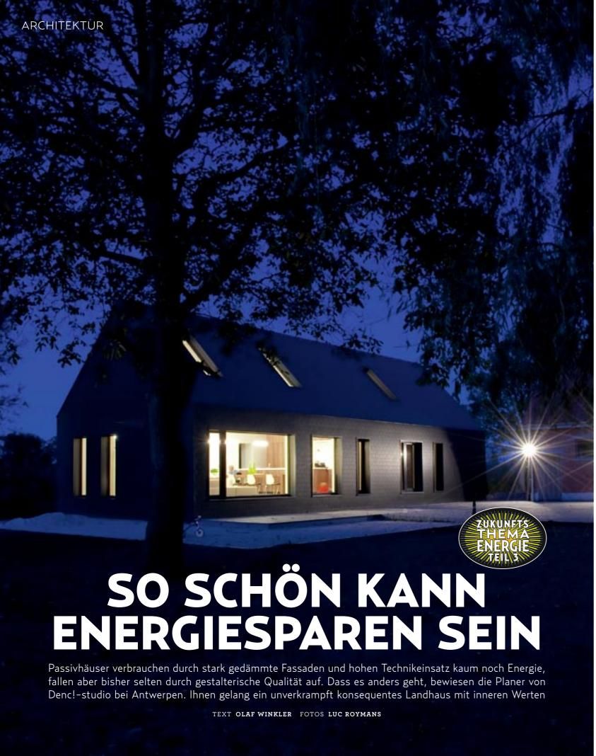
Eine homogene Hülle aus Eternit hebt bei diesem Haus die Grenzen zwischen Fassade und Dach auf. Typisch für ein Passivhaus sind die nach Süden orientierten Wärmeschutzfenster, die Sonnenwärme einfangen, während große Teile der Außenwände geschlossen sind. Gar nicht typisch für ein Passivhaus ist hingegen der firstoffene Innenraum, der Großzügigkeit vermittelt. Die eingestellte Holzbox nimmt auf zwei Ebenen Bäder und Schlafzimmer auf.
