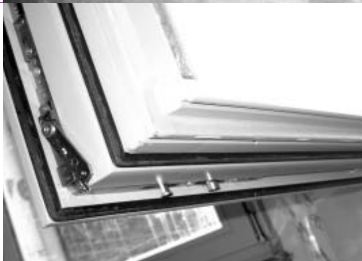
BEMERK DE DUBBELE RUBBERDICHTING EN MEERPUNTSSLUITING VOOR VERBETERDE LUCHTDICHTHEID.
