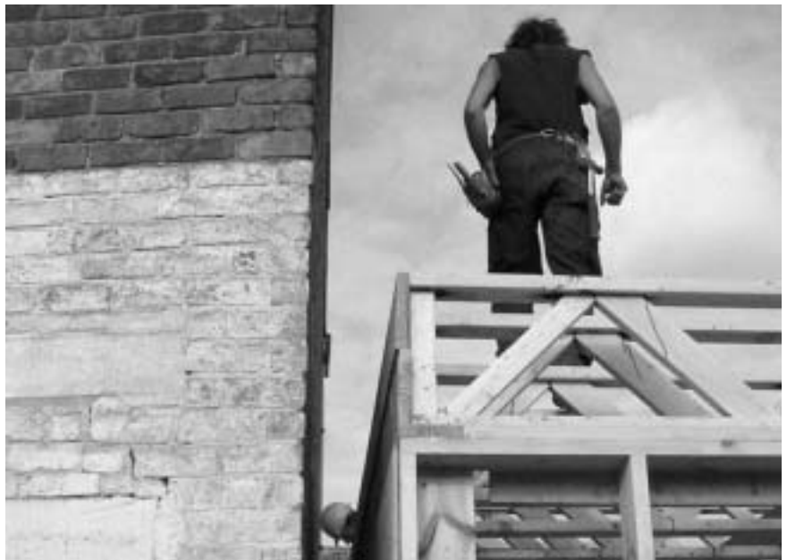
FOTO 1: DE TUSSENVLOER EN HET DAK STEUNEN OP DE ZIJMUREN ZODAT DE DRAAGBALKEN EVENWIJDIG LOPEN MET DE STRAAT- EN TUINGEVEL.
