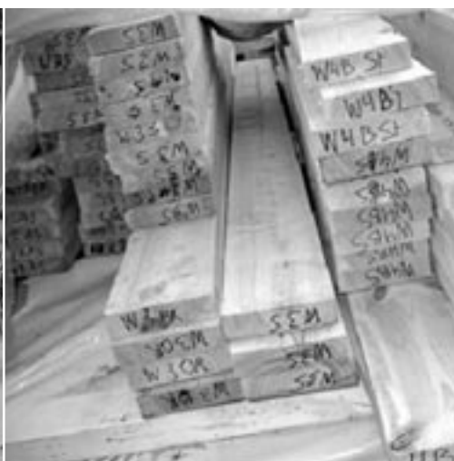
HET HOUTWERK WORDT VOORGEZAAGD OP DE WERF AANGELEVERD.
