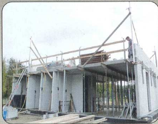
Alleen de dragende wanden en enkele niet-dragende binnenwanden worden in kalkzandsteen opgetrokken. Rondom die dragende structuur (Brick) komt nog een mantel in houtskeletbouw (Wood). Samen vormen ze de hybride Brick 'n Wood bouwmethode.
