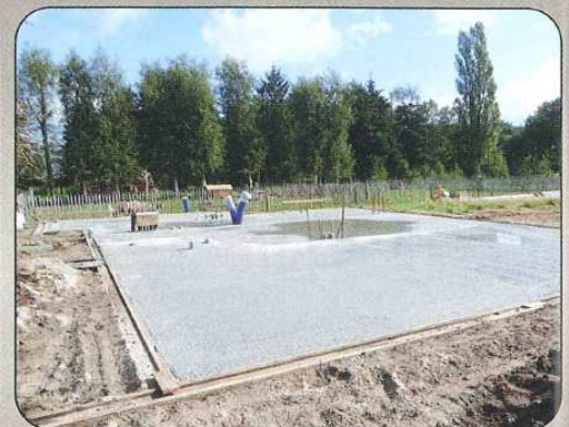
De funderingsplaat is gegoten. Hier bovenop komt de isolatie. De plaat zelf ligt draagkrachtig rechtstreeks op de ondergrond.
