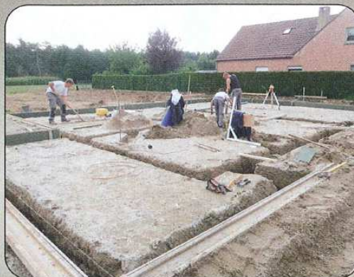
De funderings sleuven worden gegraven en de afvoerleidingen ingegraven.
