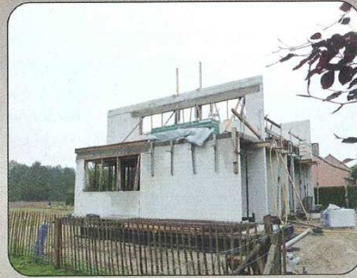
Het resultaat na 1 maand: de massieve ruwbouw is quasi voltooid.
